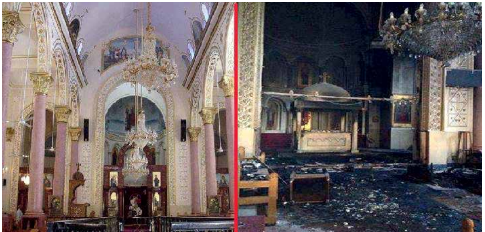
Kirche in Homs - vor (links) und nach der Zerstörung
